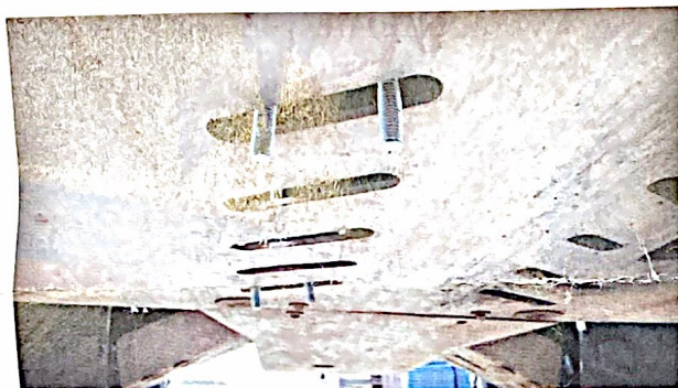
Obr. 1: Navlečení prvního páru třmenů
